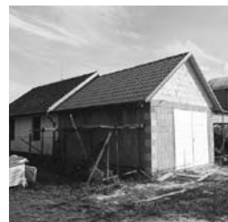
Rozšírenie filtračnej stanice
