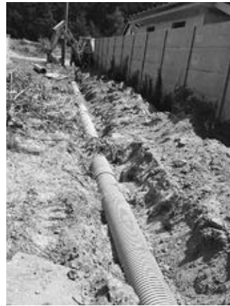
Dažďová kanalizácia prepoj Kozia a Nad Jazierkom
