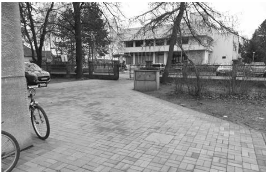
Začalo sa s úpravou vstupu do ZŠ.
