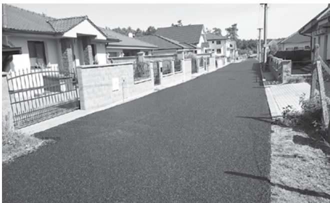
V obci sme vyasfaltovali 875 m miestnych komunikácií novým asfaltom
