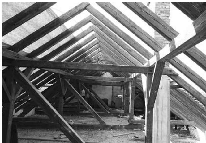
Výmena strešnej krytiny na našej škole
