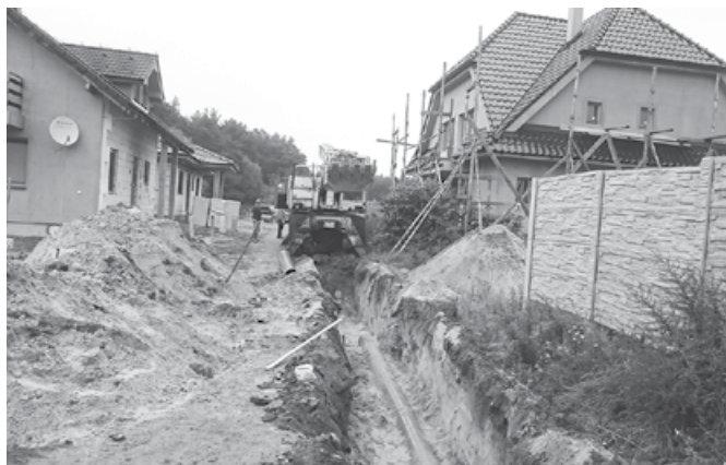
Vubudovali sme takmer 280 m kompletných inžinierskych sietí
